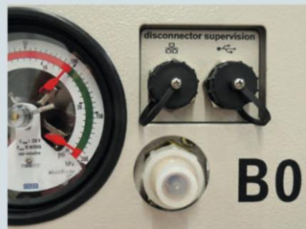
Interfaces USB y LAN para control visual de las posiciones del seccionador de tres posiciones
