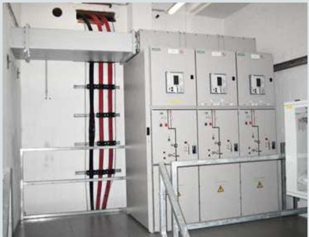
Ejemplo de una evacuación fuera de la sala de la subestación
