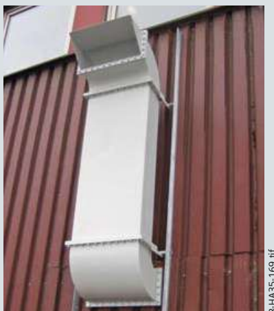
Ejemplo de una evacuación fuera de la sala de la subestación
